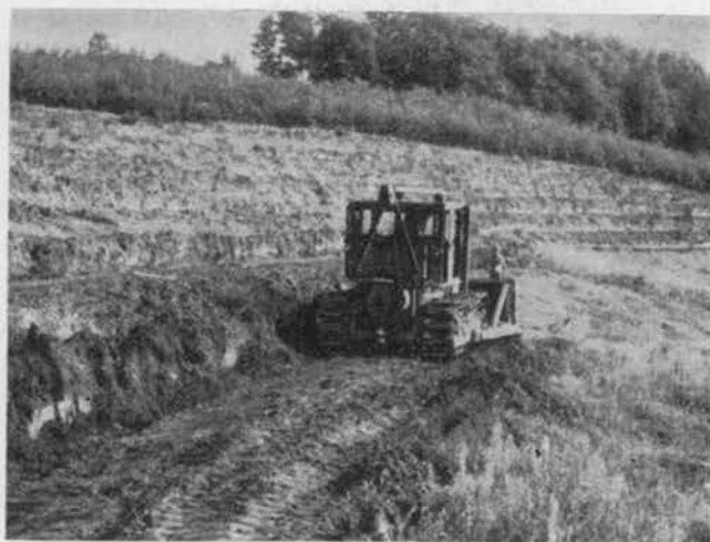
1. ábra. Teraszkészítés Sz-100 jelű erőgépre szerelt D-157 típusú tolólapal
