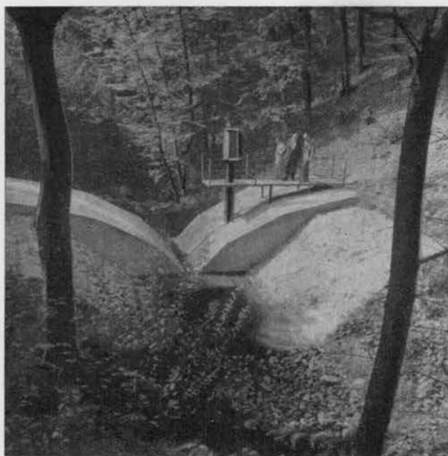
4. ábra. A Thomson-bukó a felváz felől nézve. A mérőakna a 4 m hosszúságú csillapítócsatorna közepén csatlakozik be. Az átbukási szintet 4 napos HWK—P4 rajzoló regisztrálja
