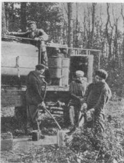
3. ábra. A platós kocsi a 3000 literes lajttal, a keverőgéppel és a védőanyag elkészítéséhez használt egyéb edényekkel. A kép előterében a háti tartály feltöltése és az elől álló munkás kezében az automatikus utántöltésű kefe látható
