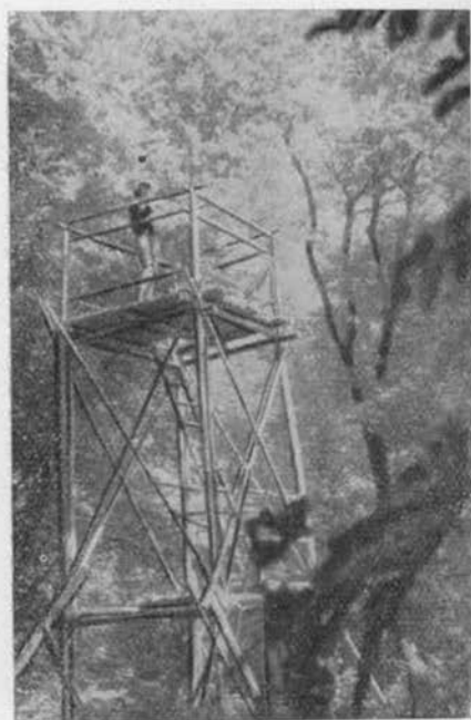
2. ábra. A bükk koronájába épített állványzat a fenológiai és virágzásbiológiai megfigyelések céljára (Foto: Varga G.)
