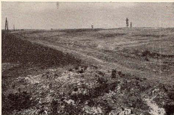
40. ábra. Fásításhoz elrendezett töltés külső, enyhén lejtő részüje a Keleti Főcsatorna balmazújvárosi szakaszán (Foto: Tóth B.)
