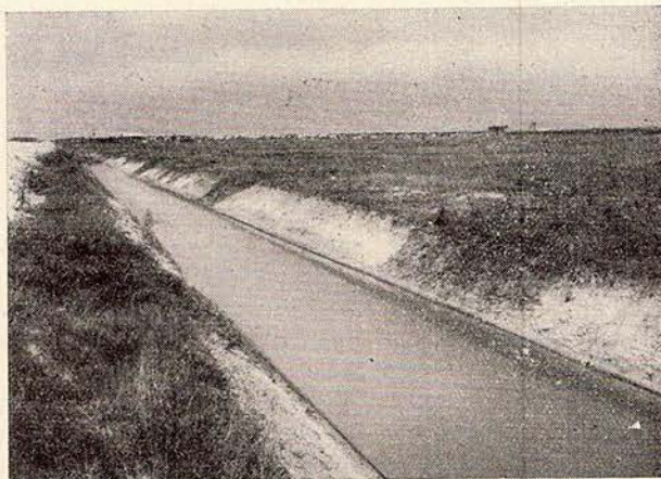
51. ábra. A szikes talaj változékonyságát jól szemlélteti a csatorna fala. A világos foltok erősen szikes keresztmetszeteket jeleznek. Hajdunánás
