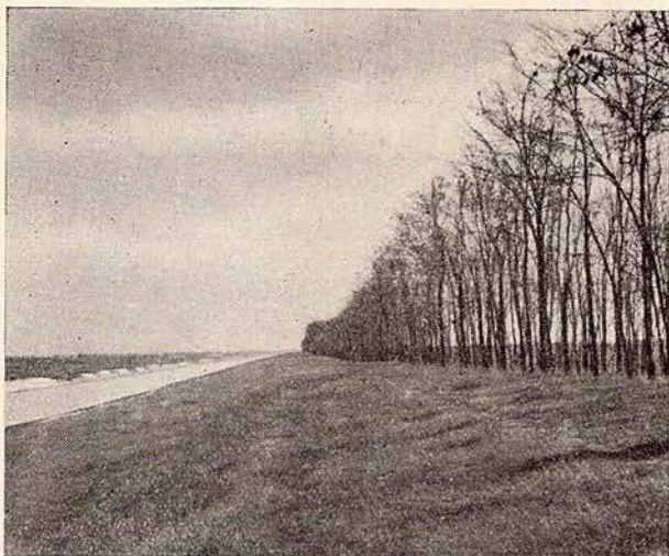
43. ábra. 12 éves akácerdősáv a Keleti Főcsatorna depóniáján. A csatornameder falán látható fehér foltok jelzik a talaj szikességét. Hajdúnánás (Foto: Tóth B.)
