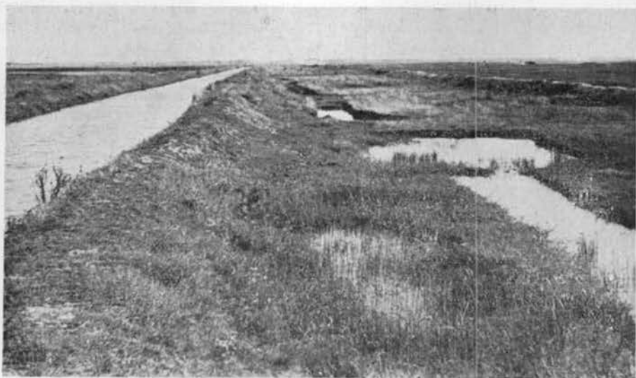
30. ábra. Időlegesen víz alá kerülő terület az elosztó csatorna mentén
