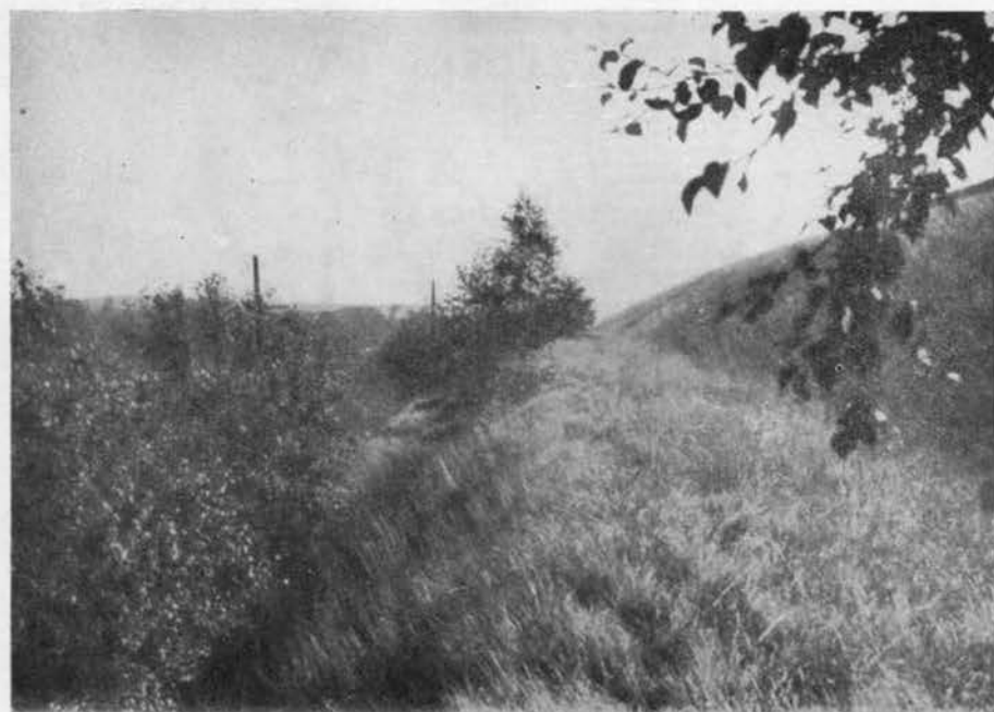
64. ábra. Fűvesítéssel és fásítással kombinált teraszos rézsű-biztosítás a Lauchhammer melletti barnaszén hányókon
