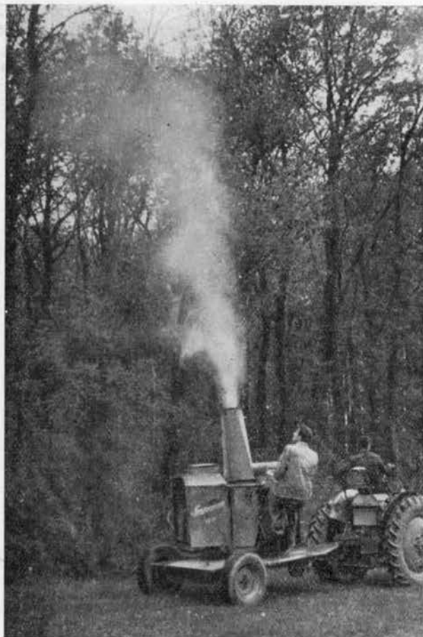
21. ábra. A „Swissatom 2000” permetező-porozógép (Foto ERTI)
