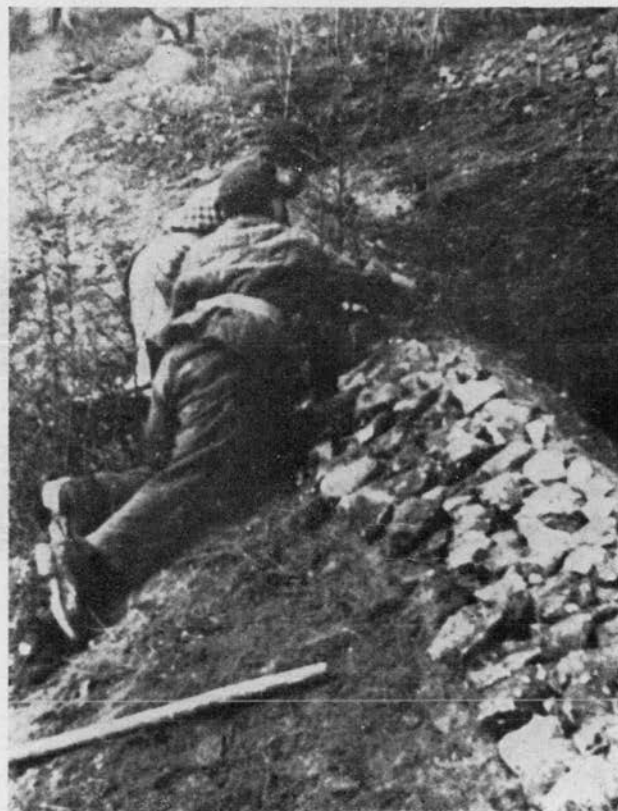
49. ábra. A kész árok, vízfogó törmelék-sánc kiképzése a völgy felőli oldalon.
