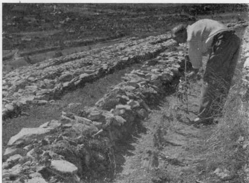
34. ábra. Arkos (ugróarkos) kiképzés. Sziklás, törmelikes 15^\circ -os és ennél meredekebb lejtőn alkalmazandó. Egymás alatti távolsága 2–3 m, amit a törmelékesség és meredekség mértéke szab meg.
