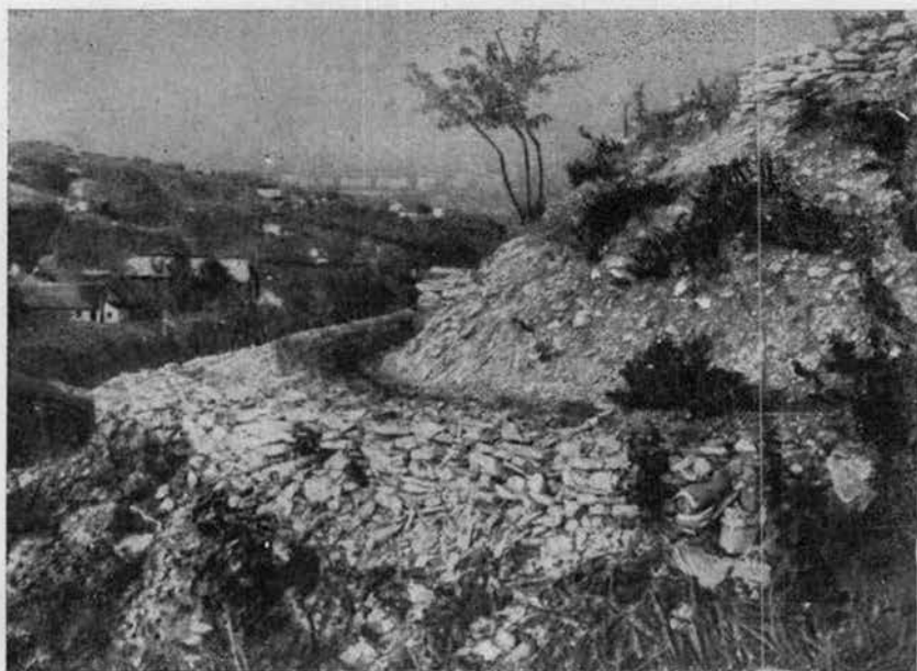
37. ábra. Arkos-terraszos, a közbeeső részeken fészkes vagy gödrös kiképzés kombinációja; 10–15°-os reliefben, törmelékes részeken és dús gyepzetben, kisebb kúpos kiemelkedések esetén alkalmazható.
