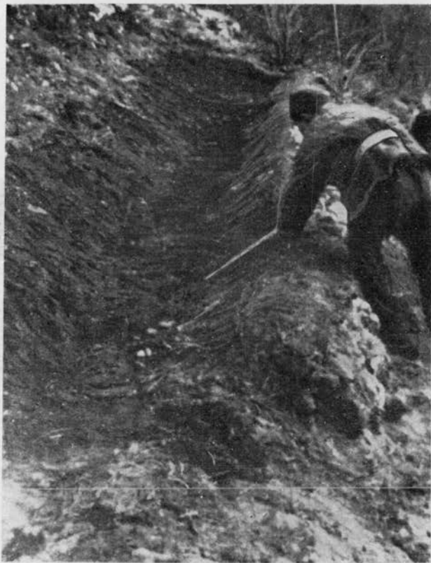
48. ábra. Lerészült árokban az ültetőföld már be van helyezve. Az ültetőföld felszínének kiképzése begy felé dőléssel.
